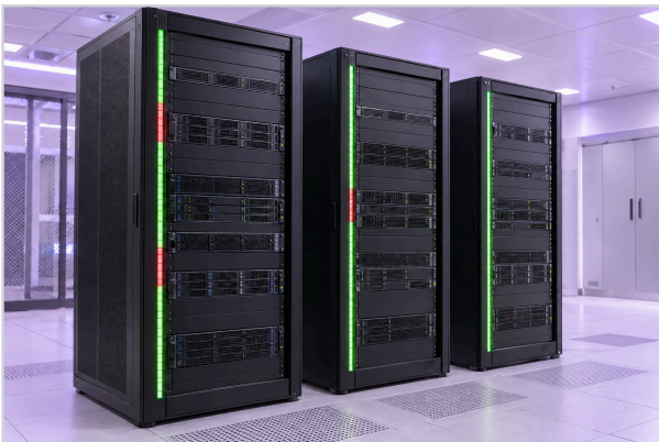
ラックの状態表示例：指定した異常箇所は赤、正常状態は緑。
